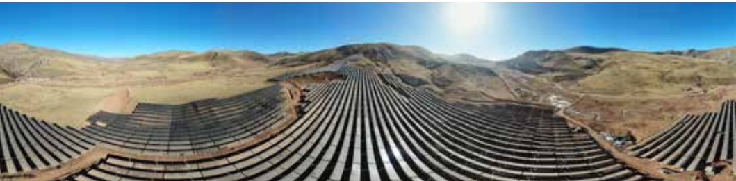
大唐江达乾裕光伏电站
