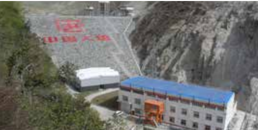
援助西藏无电地区水电项目——大唐波堆水电站
