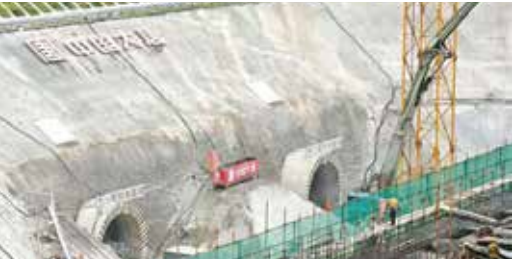
西藏首个超百万装机水电站 ZL 电站开工建设
